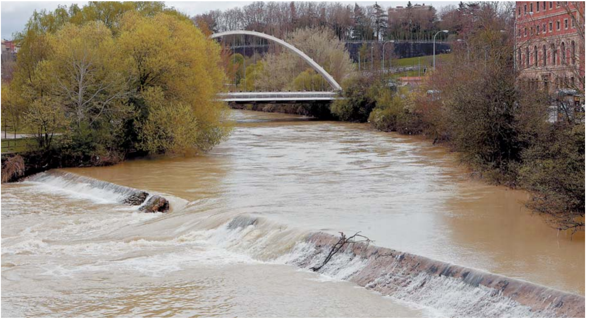
La presa de Santa Engracia, ayer, vista desde el puente del mismo nombre. De piedra de sillería, tiene unos 65 metros de largo, y está roto en dos puntos.
