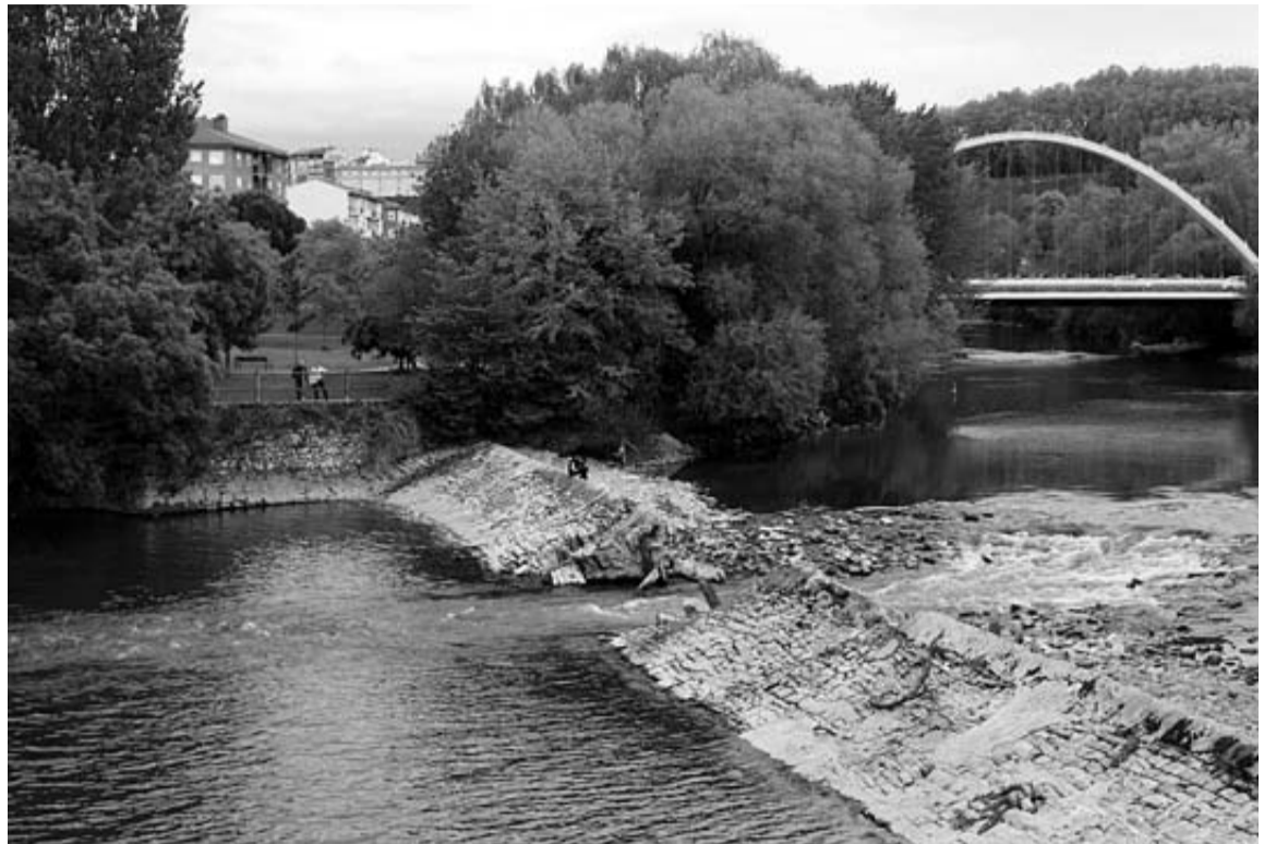
El azud de Santa Engracia, con estructura de madera y piedra. Al fondo, el puente de Oblatas.
