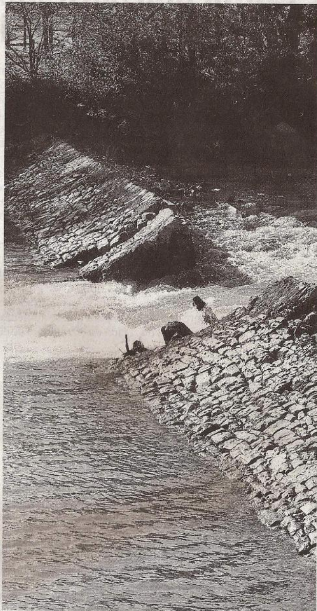
Vista de la presa de Santa Engracia. Foto: Patxi Cascante
