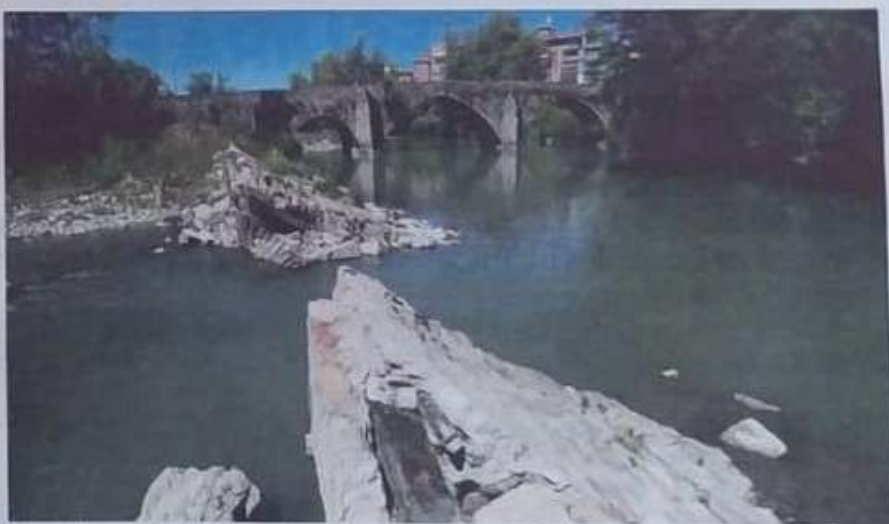
Vista de la presa de Santa Engracia, rota parcialmente desde 2018. Foto: Mikel Perro
