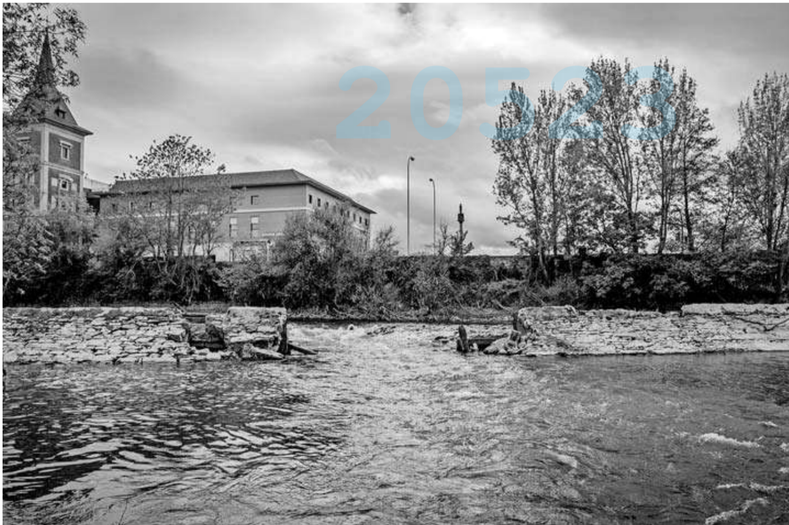
Como se aprecia en la imagen, la rotura del azud por la avenida de agua afectó a su parte central.
